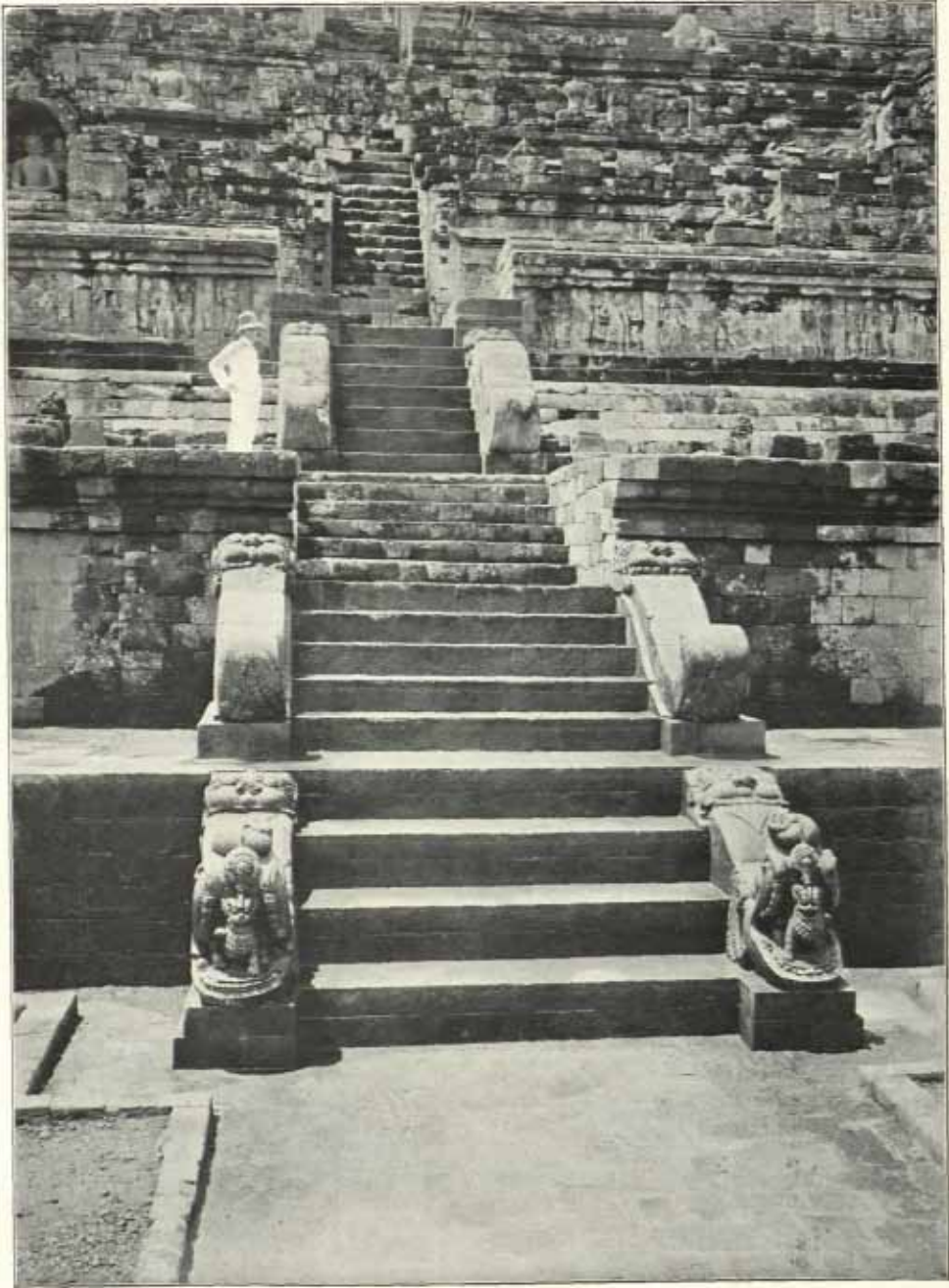
Boroboedoer. — Trappen, voerende van het stoepa-plein naar de eerste gaanderij, na restauratie.
